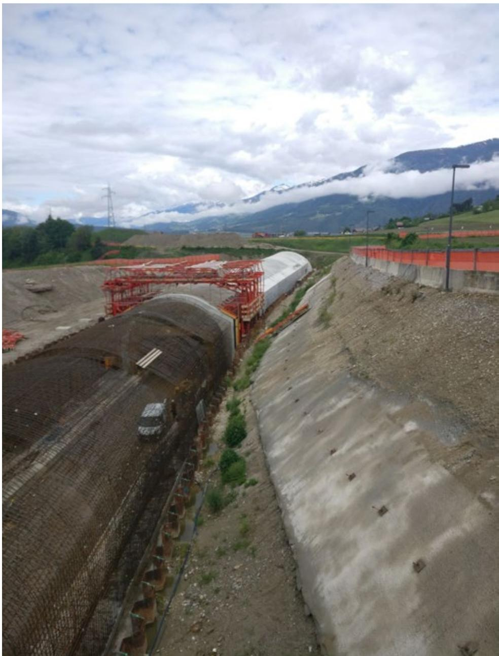
**Zur Erinnerung:** Die geplante Länge für den Tunnel der Umfahrung Percha beträgt gesamt 2.317 m, wovon 1.685 m mit bergmännischem Vortrieb und 632 m im offenen Aushub realisiert werden.
